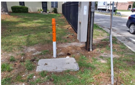
Image 4-33: Conduit Pullbox on SR 21
