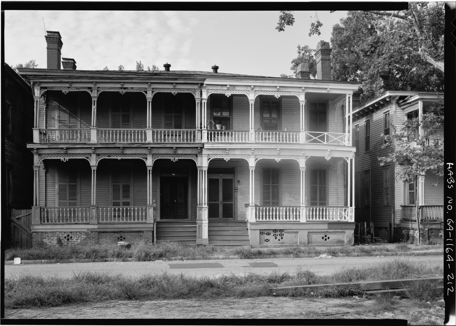
1 HABS PHOTO 1979: 209 & 211 W. WALDBURG
