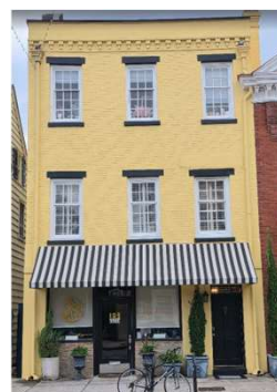
418 E. Broughton St.
