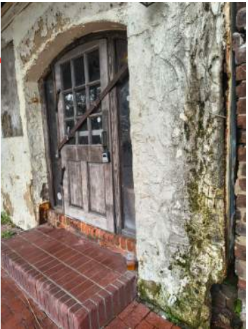
EXISTING EXTERIOR DOOR
