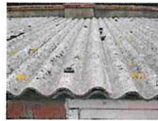
friable asbestos
